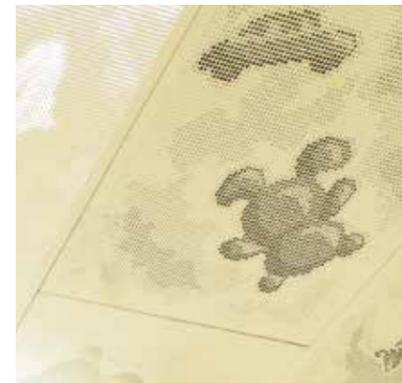
Применение перфорированных панелей – эффективный способ улучшить акустику помещения. В дополнение к улучшению акустических свойств, перфорация придаёт панелям свежий, привлекательный внешний вид.
